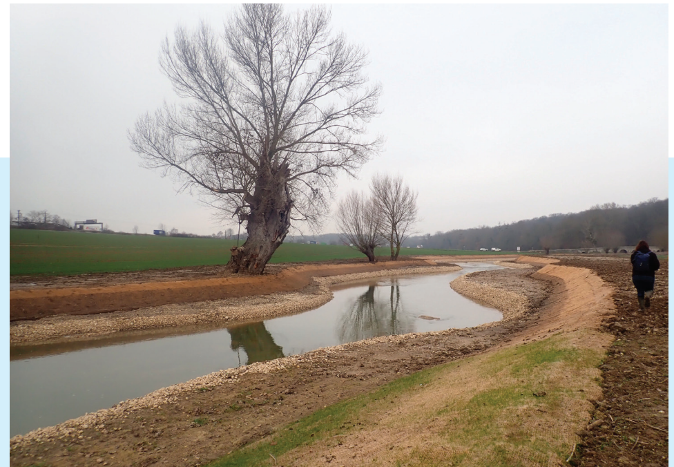
Renaturation de l'Yerres à Évry-Grégy-sur-Yerres
