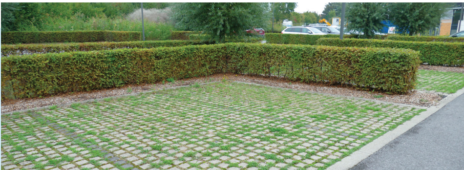
Les parkings enherbés favorisent la désimperméabilisation des sols
